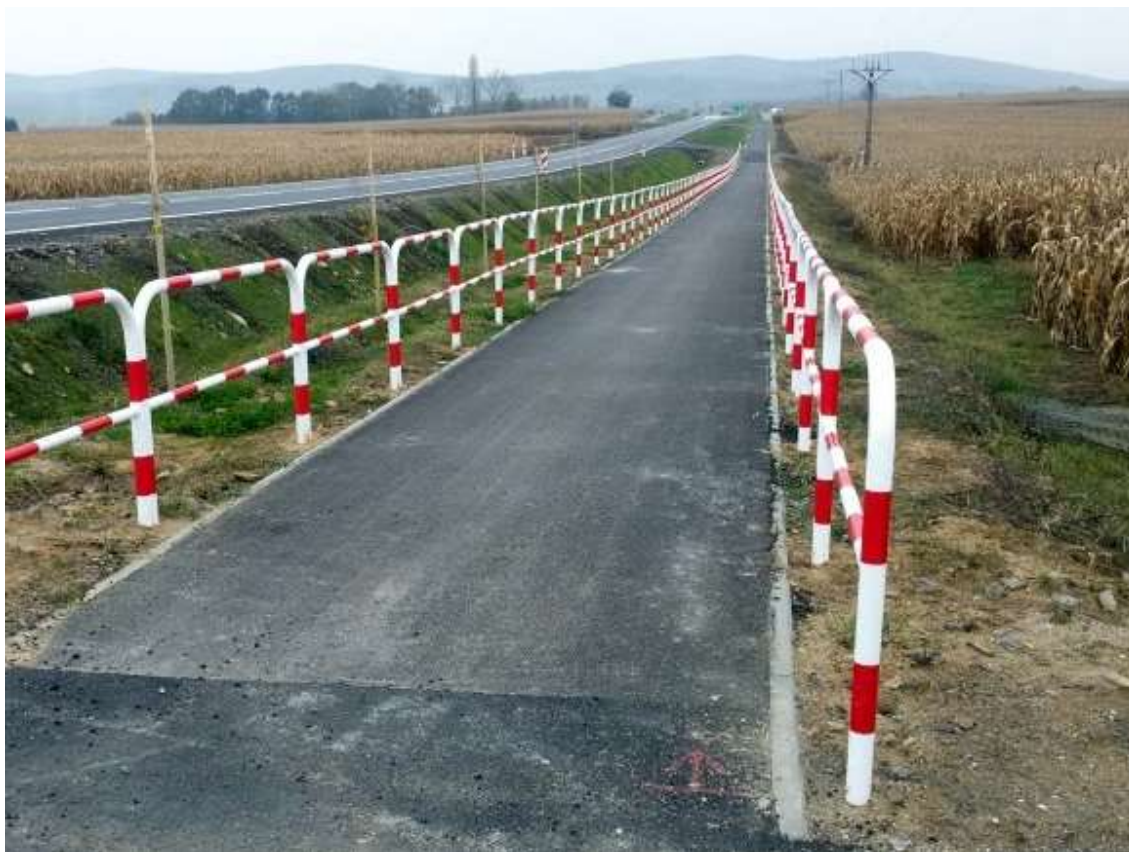
FOTOGRAFIA 6. NOWOPOWSTAŁA ŚCIEŻKA ROWEROWA PRZY DRODZE WOJEWÓDZKIEJ NR 384 NA TRASIE ŁAGIEWNIKI - SIENIAWKA
